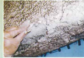
吹付けアスベストの上から吹付けロックウール
